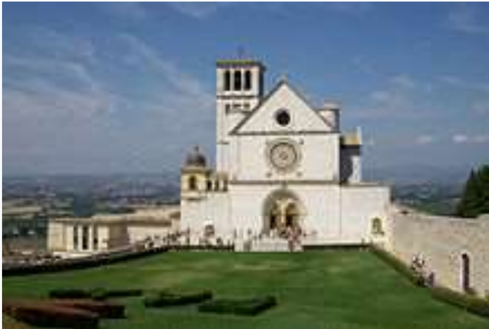
Vista frontale della Chiesa superiore
